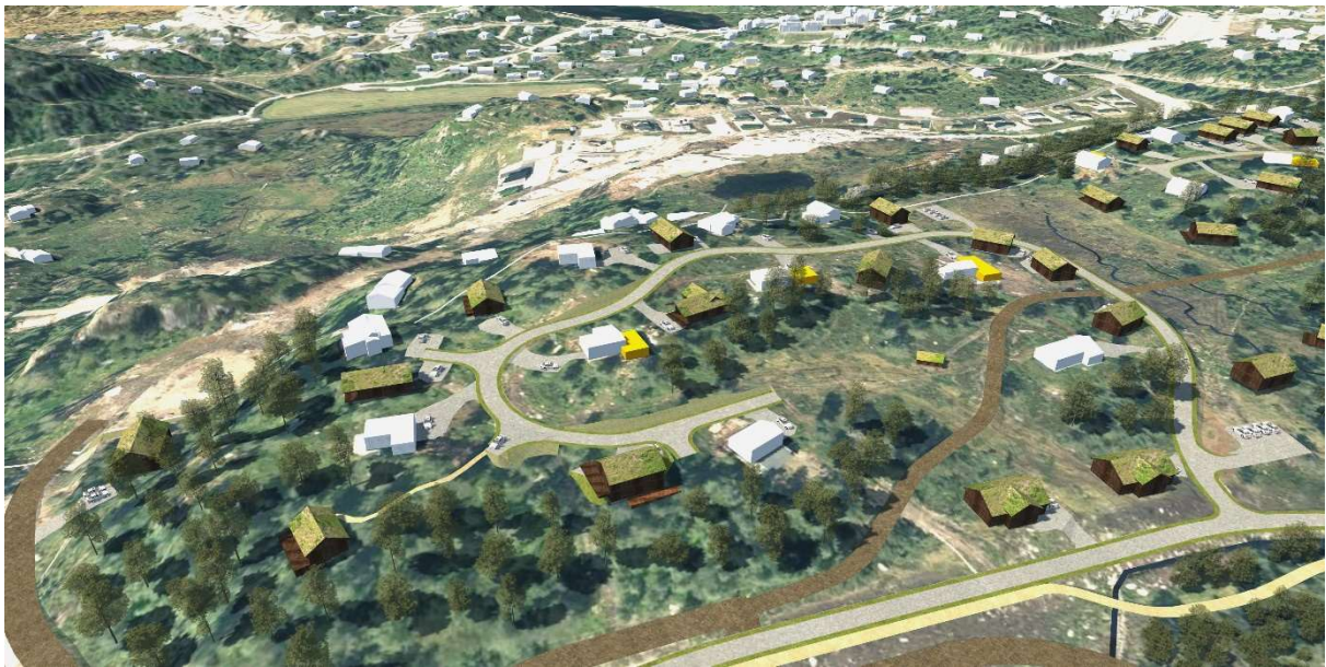
Oversiktsbilde av Bjelkelaget. Sett mot vest.
