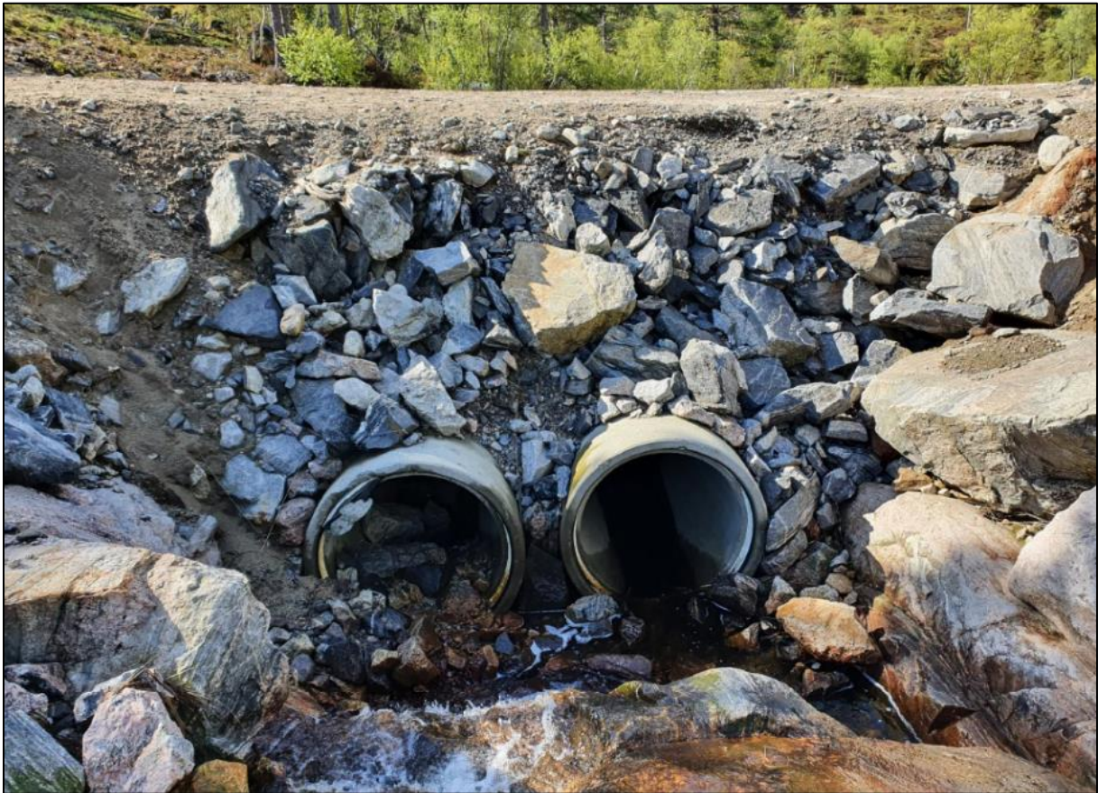
Figur 4: Bilde av kulvertinntak nedstrøms grøftet bekkestrekning.
