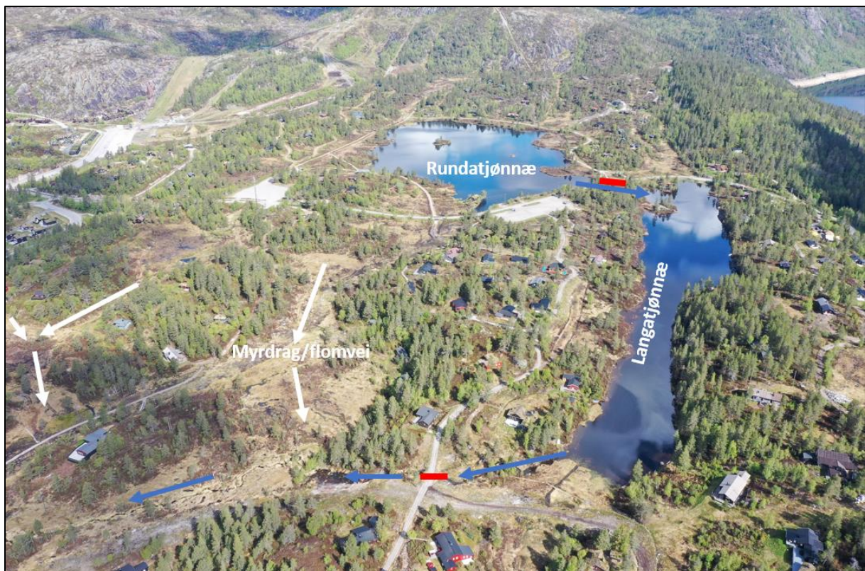
Figur 2: Illustrasjon av situasjonen i øvre del planområdet fra Rundatjønnæ og frem til grøftet strekning i nedre del. Rød linje = stikkrenner.
