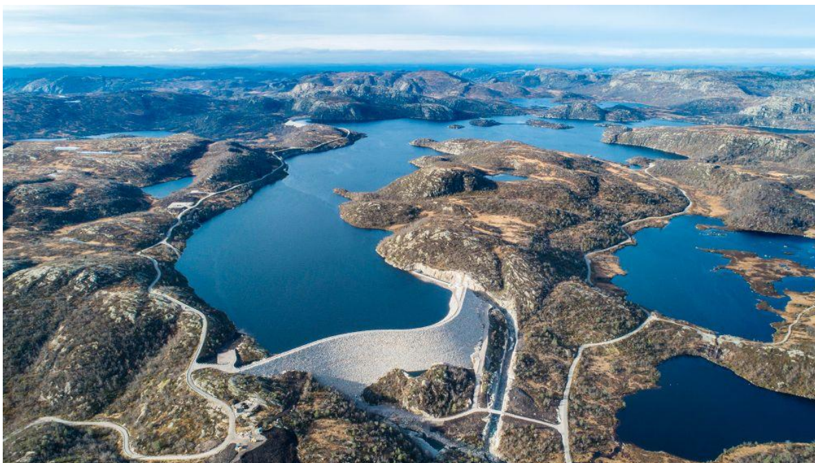
Figur 5: Skjerka vasskraftverk. Foto: Agder Energi
